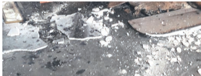
Abb. 1: Während dem Brandversuch abgefallene Gipsplatten
