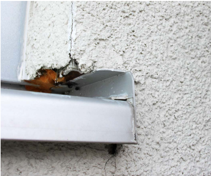
Abb. 2: Mängel im Bereich des Fensterbank- anschlusses
